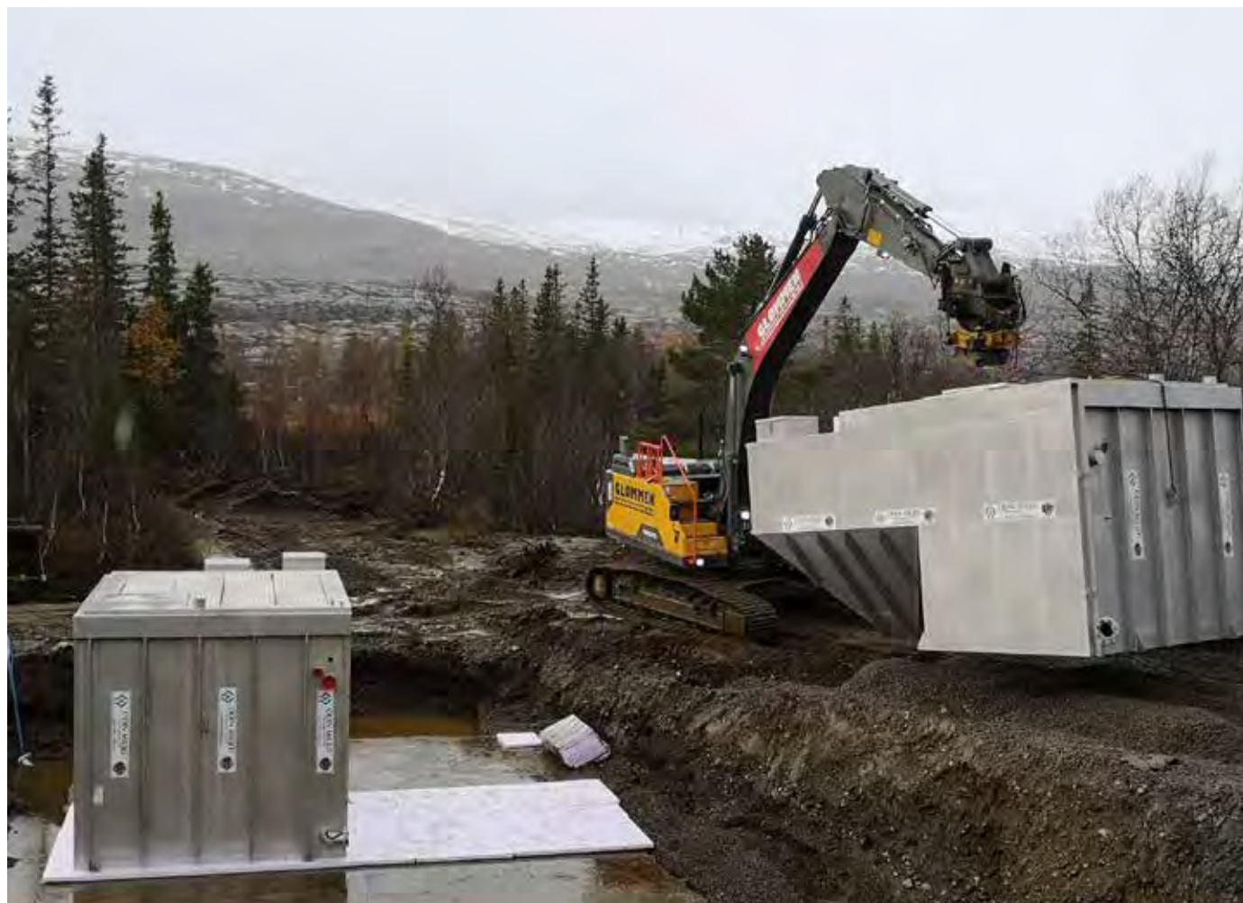
HER SER VI EN OLJESKILLER SUH-H-NS 35 som monteres i forbindelse med overvann på flyplass.
