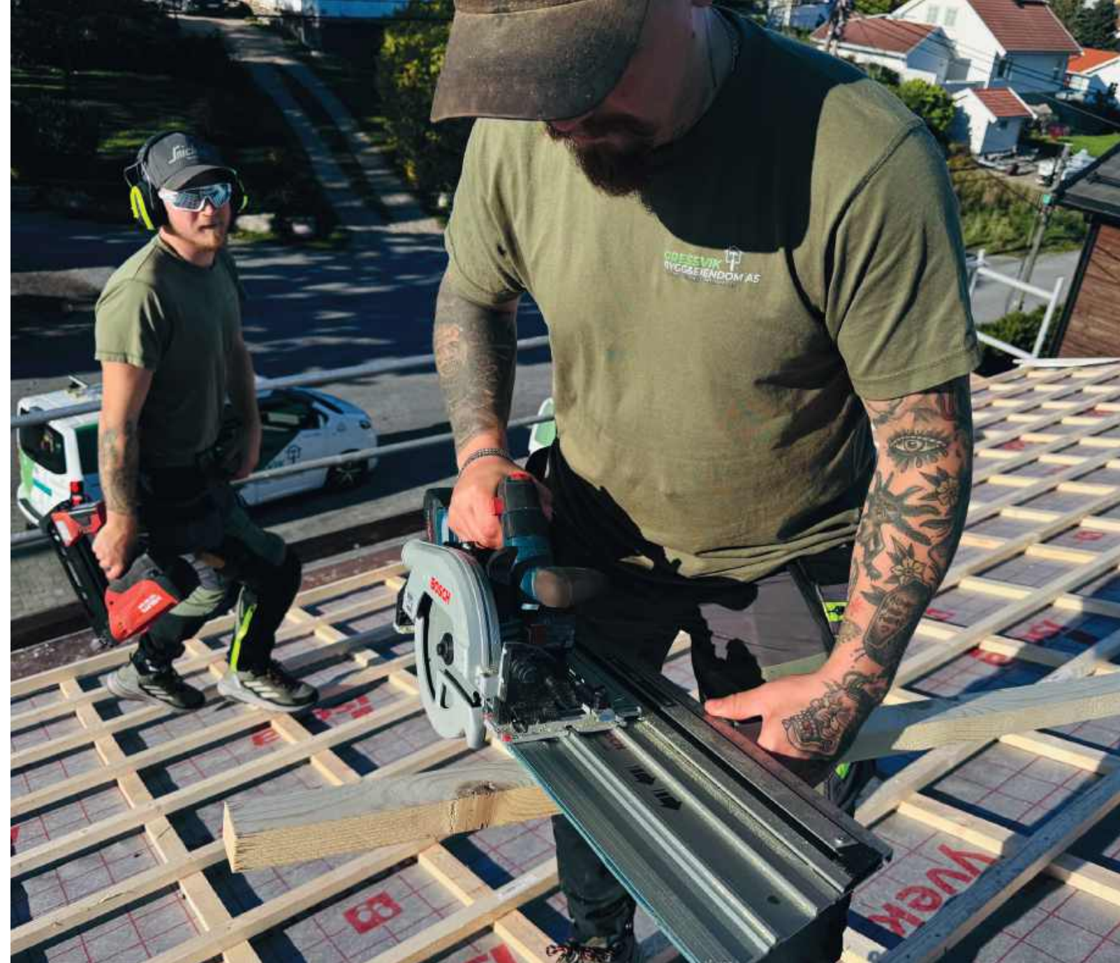
Rehabilitering av tak er en av flere spesialiteter som selskapet gjør mye av.
